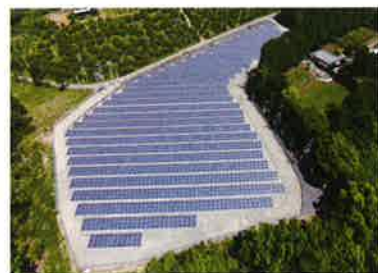
大間山発電所
